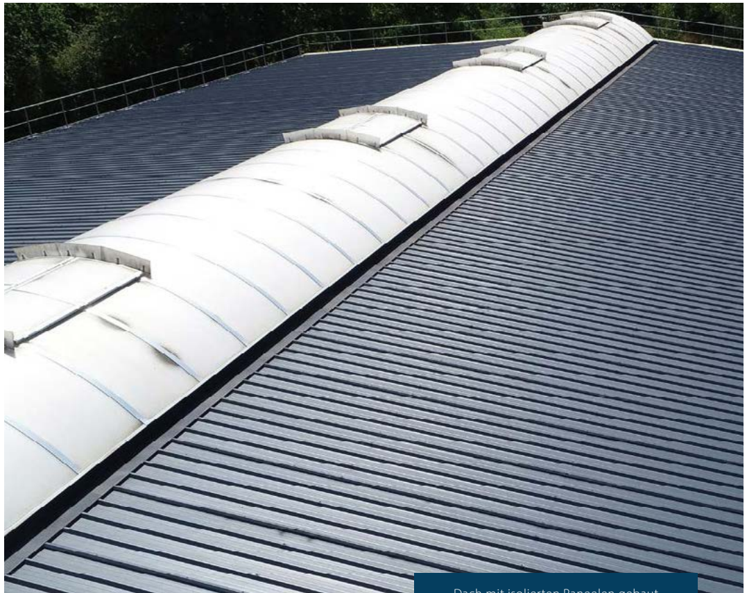
Dach mit isolierten Paneelen gebaut
