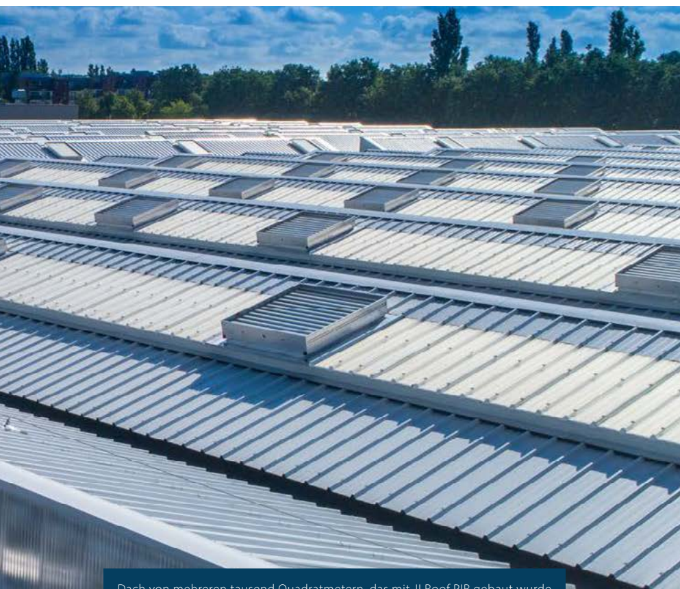
Dach von mehreren tausend Quadratmetern, das mit JI Roof PIR gebaut wurde
