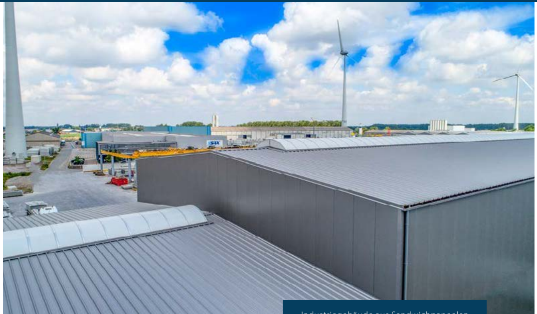
Industriegebäude aus Sandwichpaneelen
